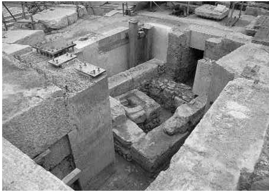
Προετοιμασία για την τοποθέτηση της φέρουσας μεταλλικής εσχάρας στον πύργο της Αθηνάς Νίκης. Στο εξωτερικό του πύργου διακρίνονται τα κατάλοιπα του πάριου κλασικού ναΐσκου. Φωτ. Κ. Μαμαλούγκας, 2004
