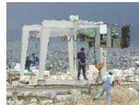
Γερανογέφυρα τύπου Π, με τις τροχίες επί του εδάφους, του εργοταξίου των Προπυλαίων.
