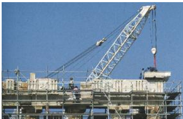
Επανατοποθέτηση των γείσων της ανατολικής πλευράς του Παρθενώνα.
