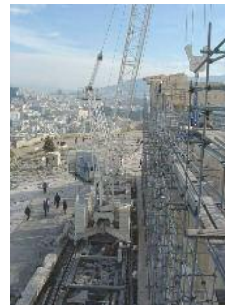
Ο περιστρεφόμενος οικοδομικός γερανός της Βόρειας πλευράς του Παρθενώνα.
