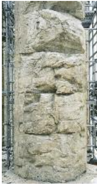
Θερμική δραύση σε κορμό κίονα του προνάου του Παρθενώνα.
