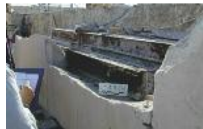
Ρηγματώσεις μαρμάρων οφειλόμενες στη διόγκωση των σιδηρών στοιχείων. (Αρχειο ΥΣΜΑ)
