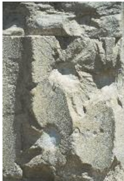
Ρήγματα από κανονιές και σφαίρες σε κίονα της δυτικής πλευράς του Παρθενώνα.
