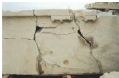
Ρηγματώσεις μαρμάρων οφειλόμενες στη διόγκωση των σιδηρών στοιχείων. (Αρχειο ΥΣΜΑ)
