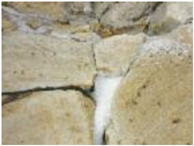
Διεύρυνση ρηγμάτων από τον παγετό.
