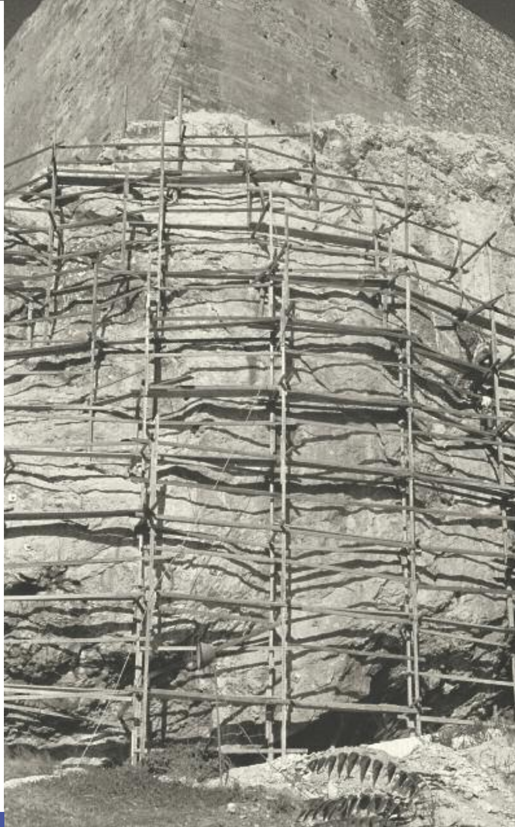
Ο φυσικός βράχος κάτω από τη νοτιοανατολική γωνία του τείχους της Ακρόπολης. Ξύλινα ικριώματα του έργου σπερώσης.
