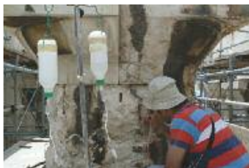
Διαδικασία συγκόλλησης εσωτερικών ρηγμάτων. Σύστημα σωλήνων σε κίονα του οπισθοδόμου του Παρθενώνα για τη διοχέτευση ενέματος.
