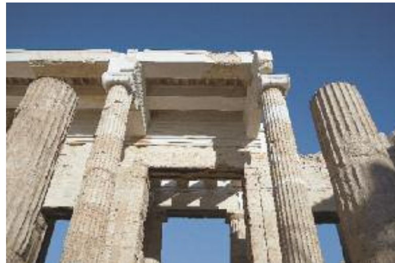
Τμήμα της οροφής των Προπυλαίων μετά την αποκατάσταση.
