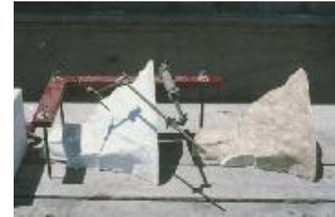
Αναστρεψιμότητα. Με την κατάλληλη τεχνική μέθοδο πραγματοποιούνται συγκολλήσεις σπασμένων αρχαίων μαρμάρων και συμπληρώσεις, χωρίς απολάξευσή τους.
