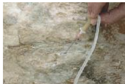
Διαδικασία συγκόλλησης εσωτερικών ρηγμάτων. Σύστημα σωλήνων σε κίονα του οπισθοδόμου του Παρθενώνα για τη διοχέτευση ενέματος.
