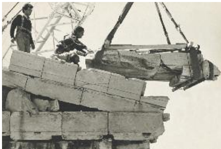
Αποσυναρμολόγηση της βορειοανατολικής σίμης του Παρθενώνα με τη λεοντοκεφαλή ψευδο-υδρορρόη.
