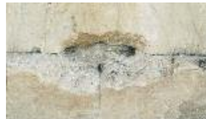
Ίχνη από τη βίαιη εξαγωγή μολύβδου για την κατασκευή σφαιρών.
