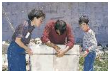
Τεκμηρίωση. Πριν από κάθε επέμβαση γίνονται συστηματικές μετρήσεις και φωτογραφίες των μνημείων.
