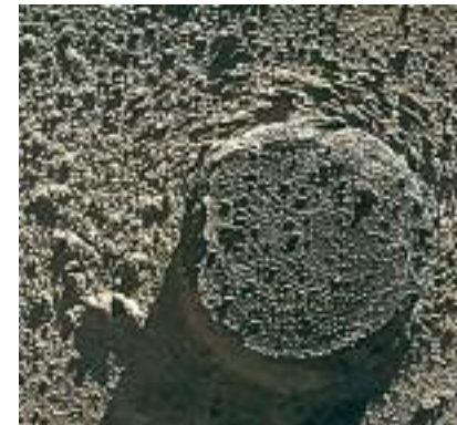
Διάφορες επικαθίσεις, αποτέλεσμα της ατμοσφαιρικής ρύπανσης. Διακρίνονται οι κόκκοι του μαρμάρου που έχουν χάσει τη συνοχή τους και σχηματίζουν κρούστα σκουρόχρωμη από την αιθάλη και τη σκόνη.
