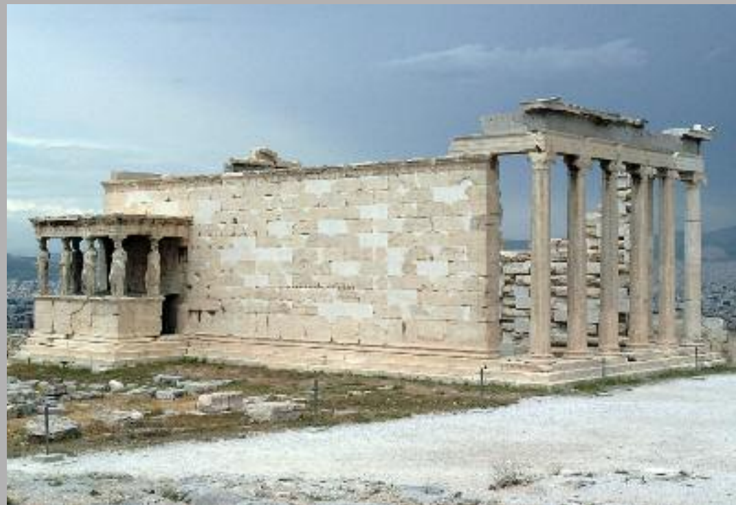
Άποψη της νοτιοανατολικής πλευράς του ναού κατά τη διάρκεια των επεμβάσεων και μετά το τέλος των εργασιών.
