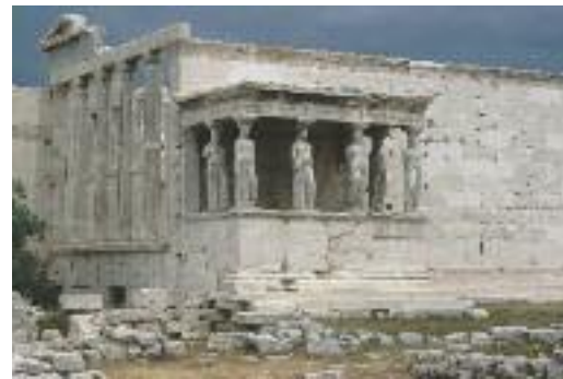
Άποψη της νότιας πλευράς του Ερεχθείου μετά την αποκατάσταση.
