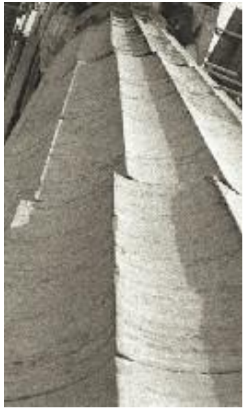
Μετακινήσεις σπονδύλων κίονα του Παρθενώνα οφειλόμενες σε σεισμό.
