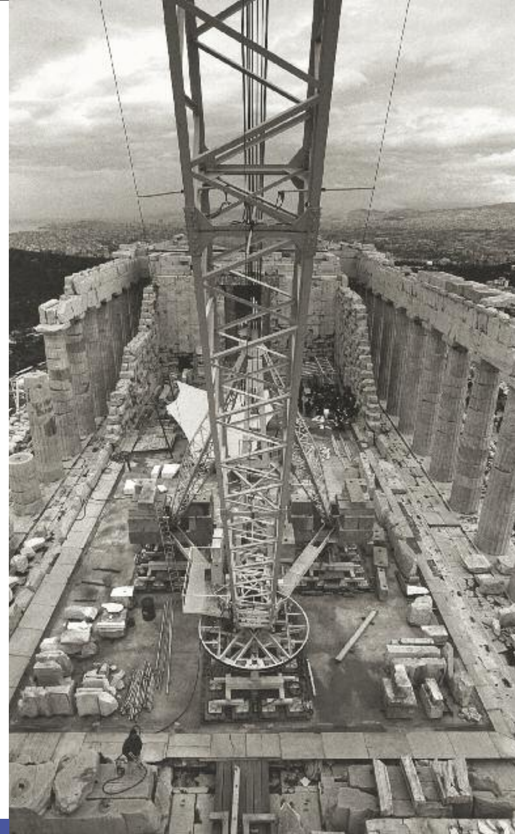
Το εργοτάξιο μέσα στον σπικό του Παρθενώνα. Δεσπόζει ο περιστρεφόμενος γερανός.
