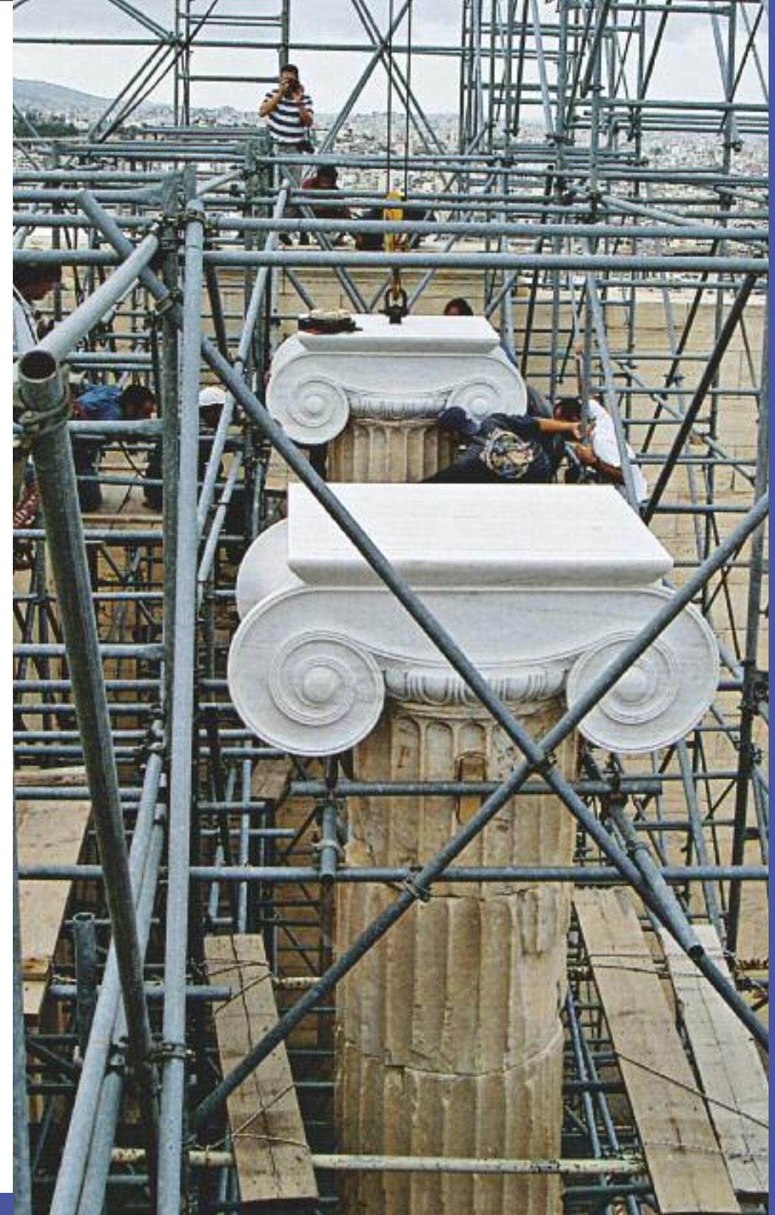
Τοποθέτηση των δύο νέων ιωνικών κιονοκράνων στην κεντρική αίθουσα των Προπυλαίων. (Ε.Π.)
