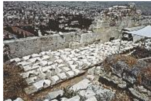
Θραύσματα φατνωματικών πλακών στο δάπεδο εργασίας, κατά την έρευνα για ταυτίσεις. (Τ.Τ.)
