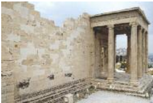
Άποψη της βόρειας πλευράς του Ερεχθείου μετά την αποκατάσταση.
