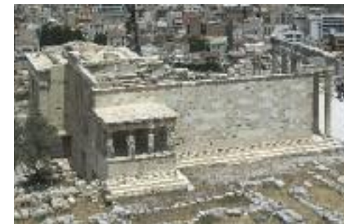
Η νότια πλευρά του Ερεχθείου. Διόρθωση παλιότερων παραποθετήσεων λίθων του τοίχου, με την απαραίτητη προσθήκη νέου μαρμάρου.
