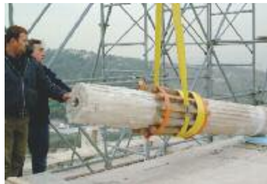
Αποσυαρμολόγηση του κιονοκράνου και μετακίνηση του μονολιθικού κορμού ενός κίονα του ναού της Αθηνάς Νίκης.
