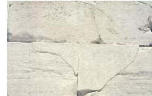
Αναστρεψιμότητα. Με την κατάλληλη τεχνική μέθοδο πραγματοποιούνται συγκολλήσεις σπασμένων αρχαίων μαρμάρων και συμπληρώσεις, χωρίς απολάξευσή τους.
