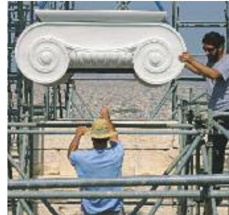
Τοποθέτηση των δύο νέων ιωνικών κιονοκράνων στην κεντρική αίθουσα των Προπυλαίων.
