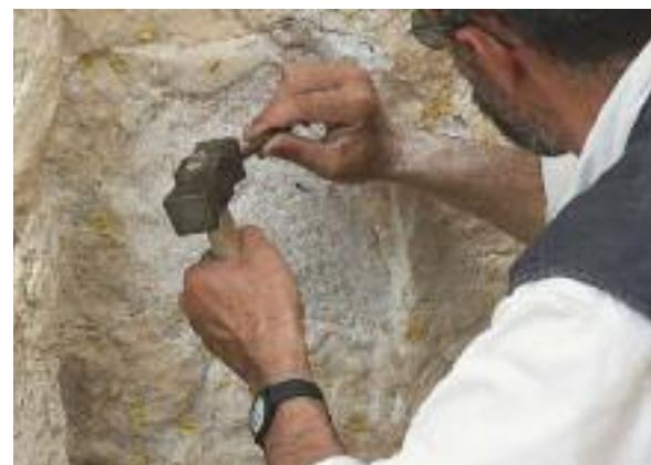
Μηχανικός καθαρισμός της επιφάνειας του μαρμάρου.
