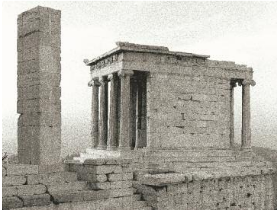
Άποψη της βορειοανατολικής πλευράς του ναού πριν την αποσυναρμολόγησή του.
