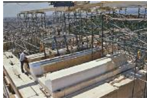
Ανατοποθέτηση δοκού της ανατολικής στοάς των Προπυλαίων. (Τ.Τ.)
