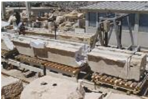
Συγκόλληση θραυσμάτων δοκού της ανατολικής στοάς των Προπυλαίων. (Τ.Τ.)
