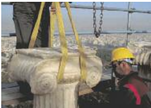
Αποσυαρμολόγηση του κιονοκράνου και μετακίνηση του μονολιθικού κορμού ενός κίονα του ναού της Αθηνάς Νίκης.
