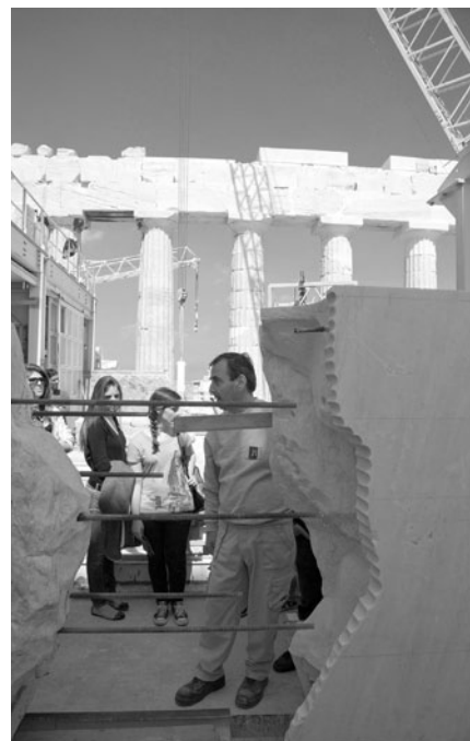
Εργαστήριο συγκόλλησης αρχιτεκτονικών μελών στο εσωτερικό του Παρθενώνα. Φωτ. Τ. Σουβλάκης, 2012
