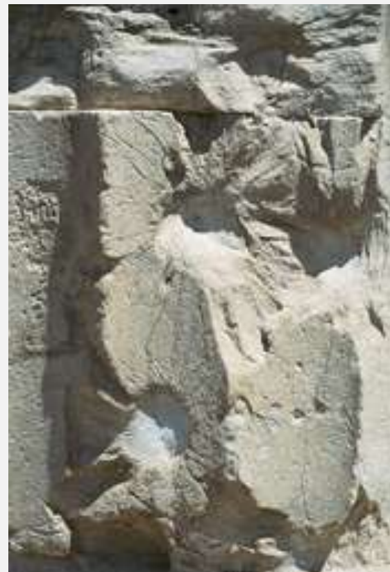
Ρήγματα από κανονιές και σφαίρες σε κίονα της δυτικής πλευράς του Παρθενώνα.
