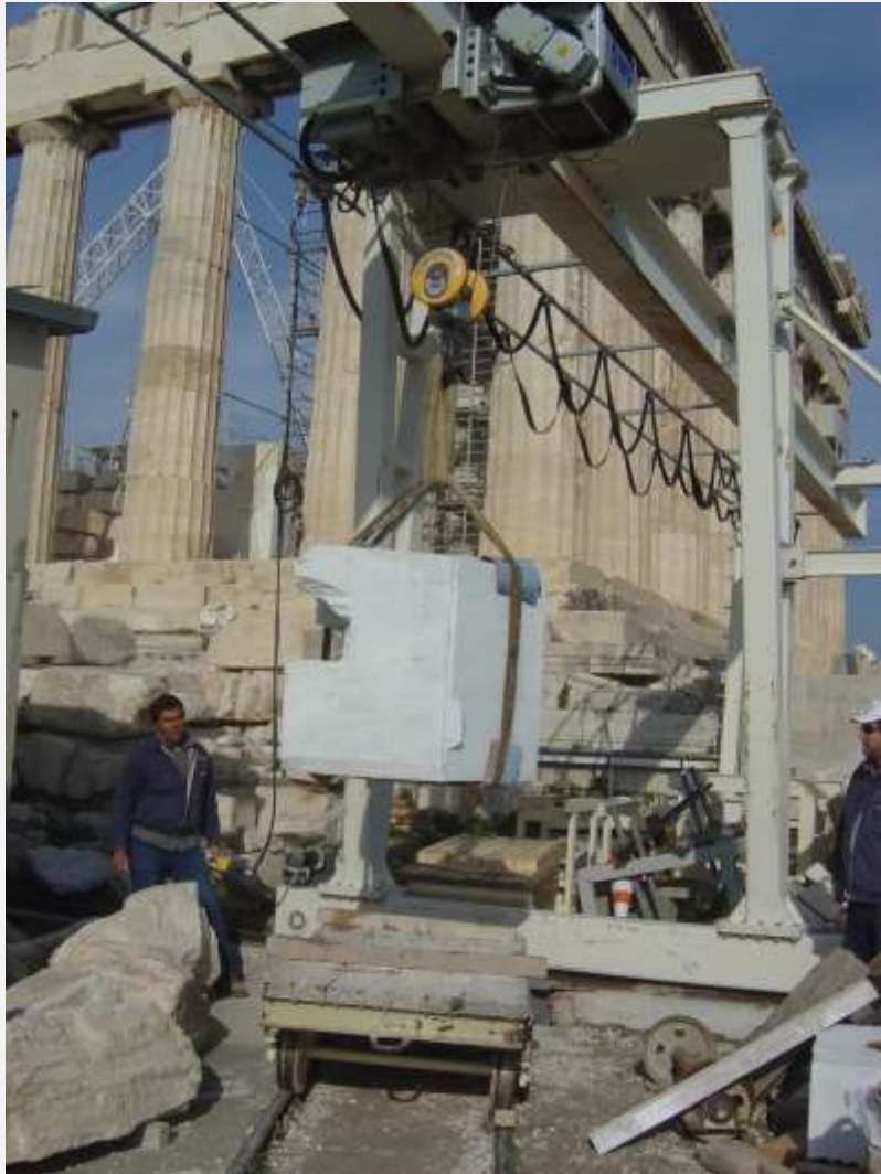
Βαγόνι και γερανογέφυρα
