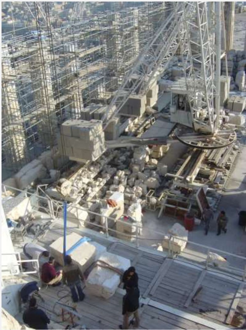
Γερανός τύπου Derrick ανυψωτικής ικανότητας 12t, εγκατεστημένος εντός του Παρθενώνα.
