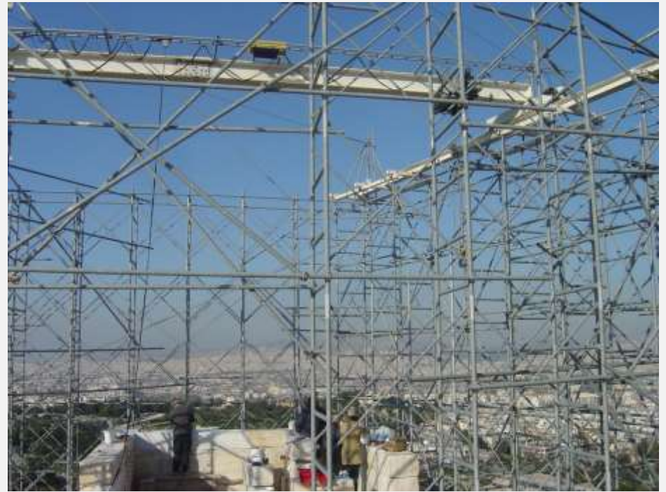
Γερανογέφυρα ναού Αθηνάς Νίκης
