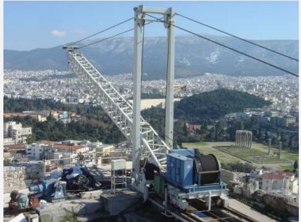
Ανακλινόμενος γερανός επί σιδηροτροχιών.
