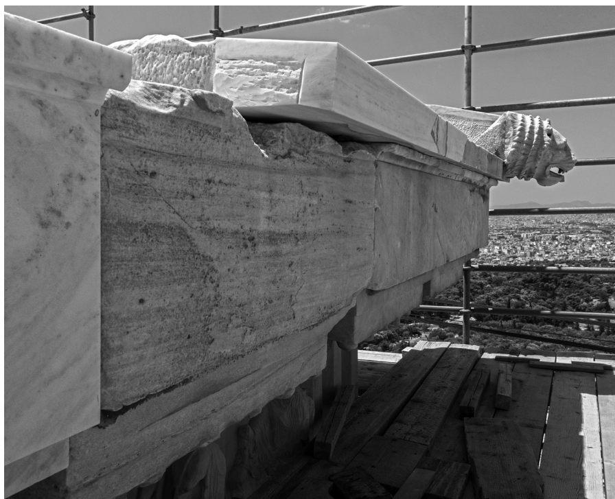
Αποψη της ΒΑ γωνίας του Παρθενώνα από Α, μετά την ολοκλήρωση της επέμβασης. Φωτ. Τ. Σουβλάκης, 2015
