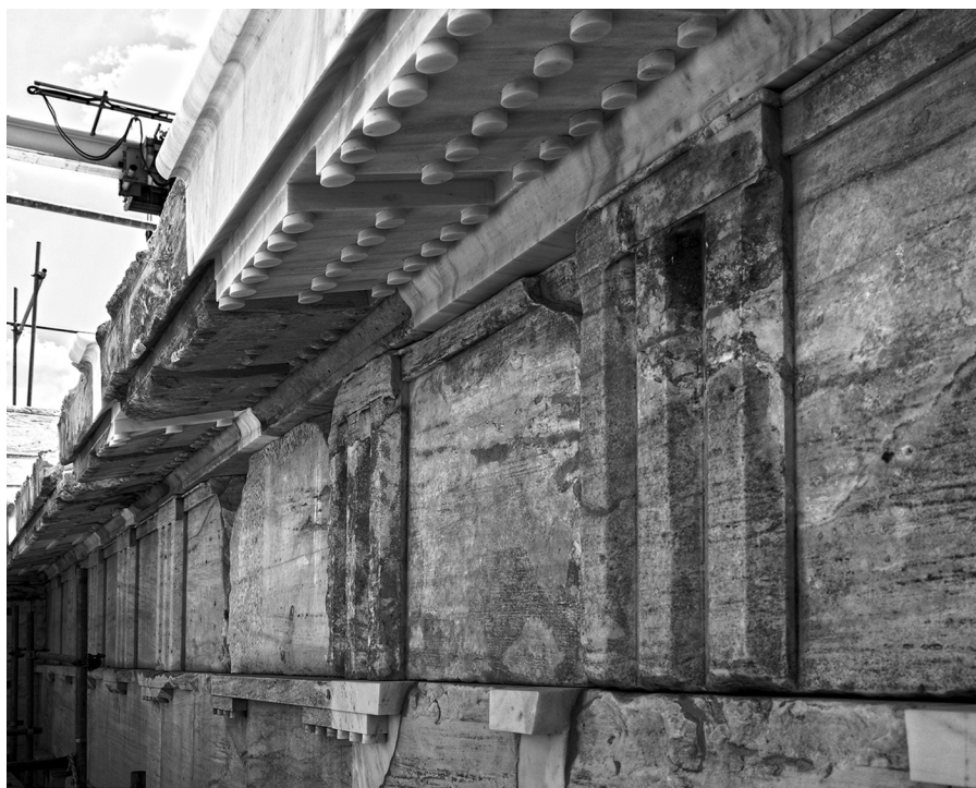
Αποψη του βόρειου θριγκού της νότιας πτέρυγας των Προπυλαίων, μετά την ολοκλήρωση της επέμβασης. Φωτ. Τ. Σουβλάκης, 2015
